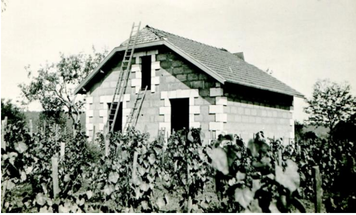
La construction de la maison Castaing en 1935.
